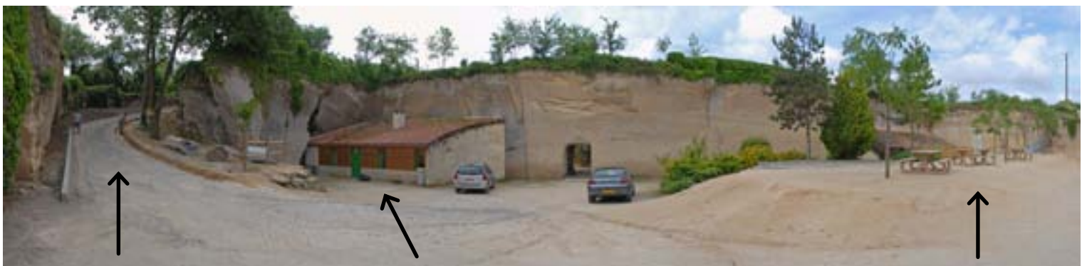
Accès : véhicules de service, restaurateurs, personnes à mobilité réduite.
